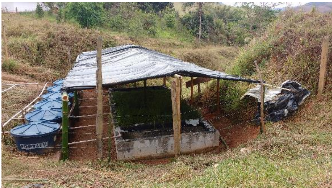
Figura 5: Vista dos SACs-EHSS cobertos para se efetuarem os testes utilizando-se o traçador
