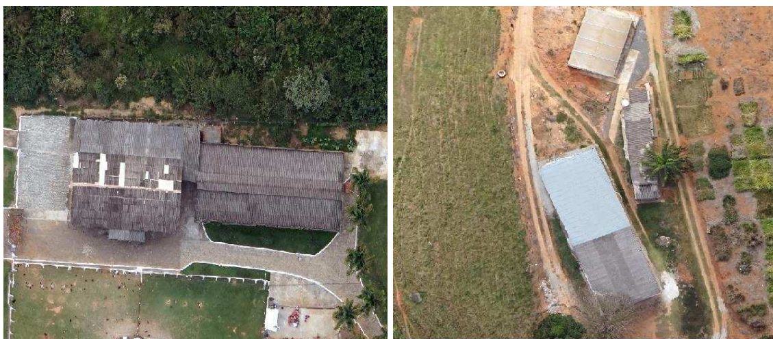
Figura 25- Problemas encontrados nas ortofotos. Sobreposição (esquerda) e deformação de coberturas (direita).
