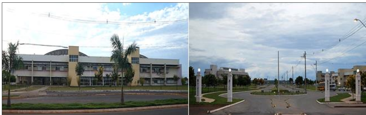
Figura 68: Pavilhão de Aulas e Pilastras UFV-CRP.
