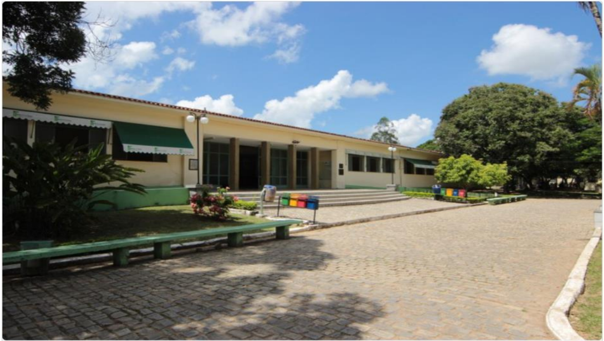
Figura 7 – Fachada atual do Prédio Central do IF Campus Rio Pomba
