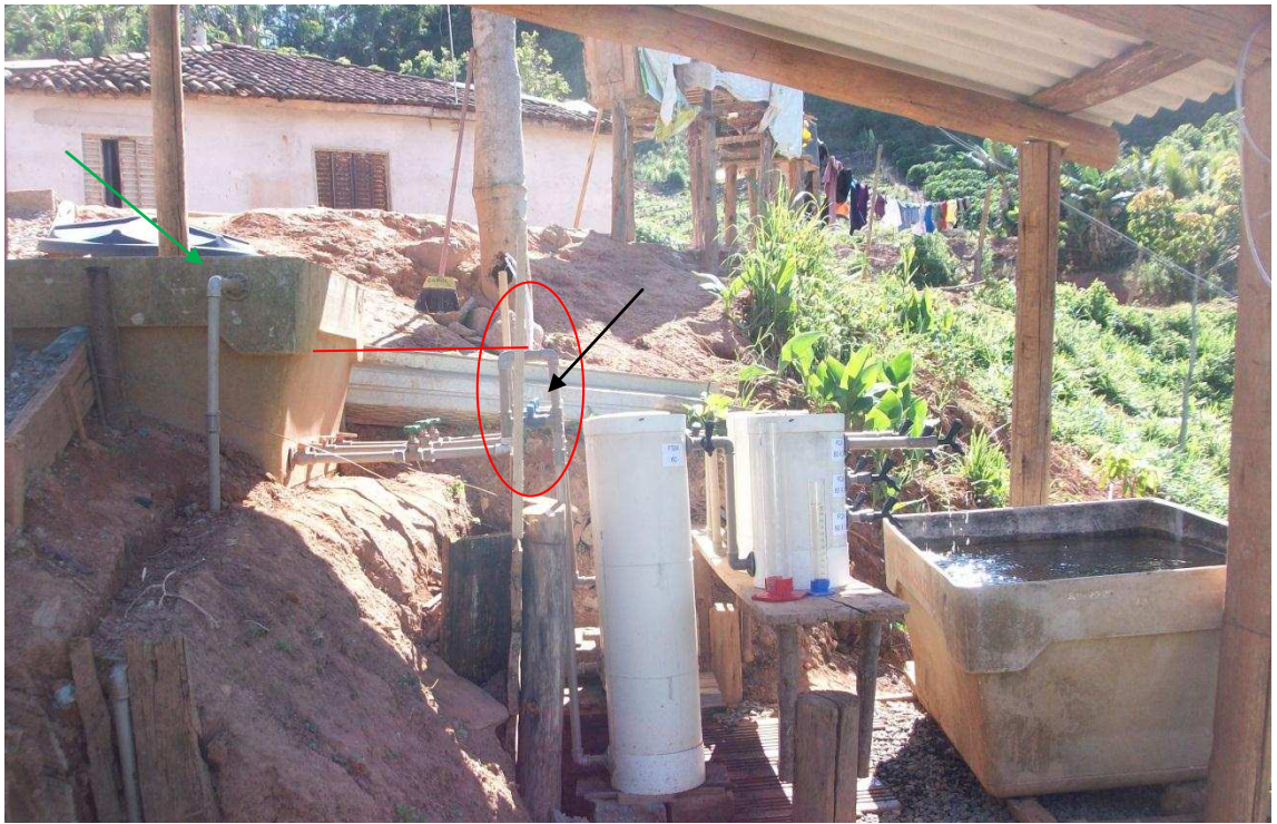
Figura 5 Detalhamento do tubo em "U" invertido e do ladrão usado no tanque receptor.
