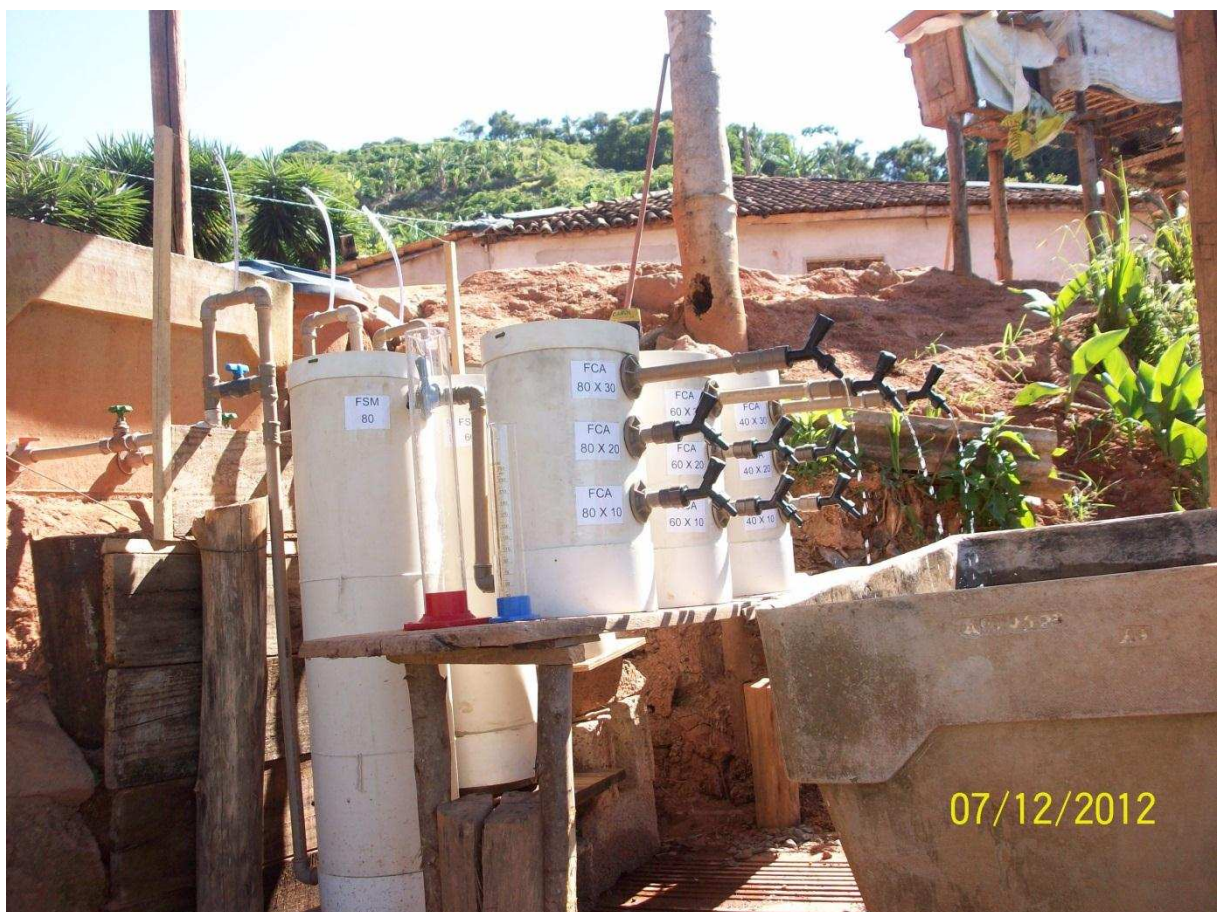
Figura 3 Filtração sequencial: Filtros de Serragem Madeira (FSM) e Filtros de Carvão Ativado (FCA)
