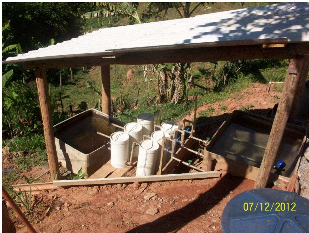
Figura 1 Vista do sistema de tratamento da água cinza por um sistema sequencial de filtração.
