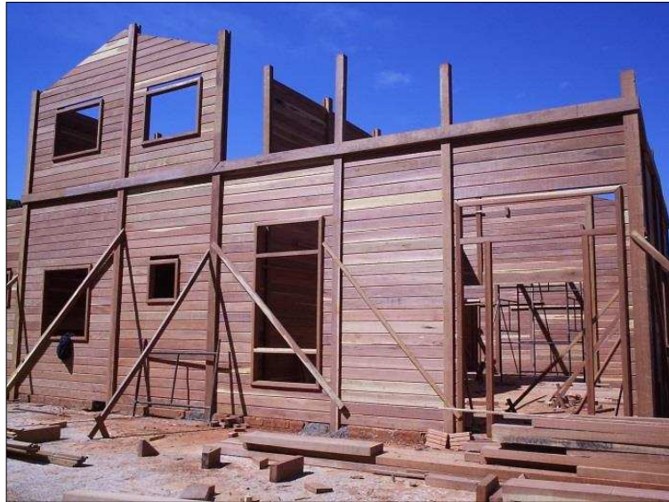
Figura 43 – Batentes de esquadrias encaixados nas peças de vedação. Fonte: Autor.
