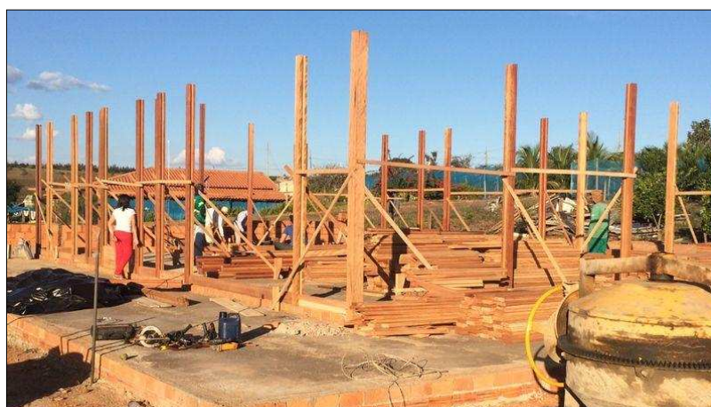
Figura 12 – Início da montagem do subsistema de estrutura portante. Fonte: Autor.
