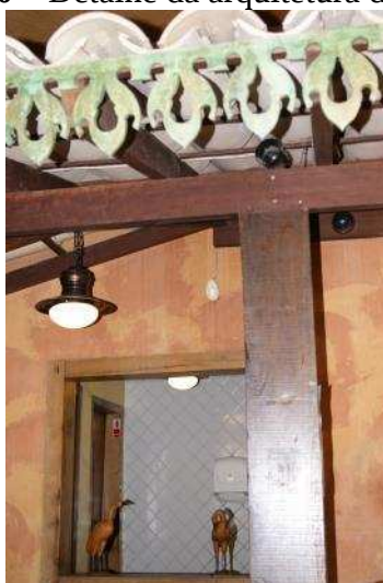
FIGURA 40 – Detalhe da arquitetura do restaurante
