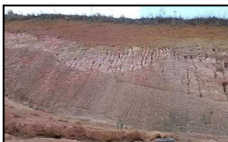
Figura 7 – Talude de coleta de solo investigado na pesquisa: Solo AERO
