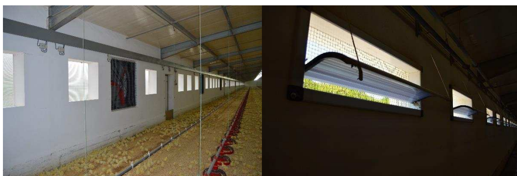
Figura 2. Vista dos sistema de ventilação, entradas de ar e luz natural no interior do aviário sólido, com isolamento térmico, para frangos de corte.
