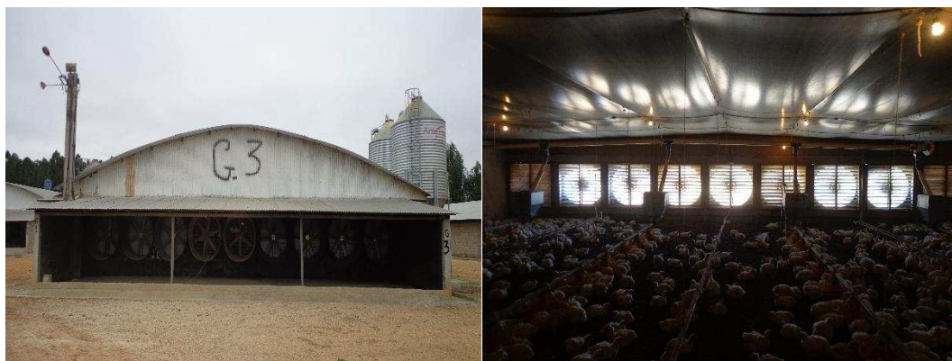
Figura 2. Vista interna e externa do sistema de ventilação do aviário sólido para frangos de corte.
