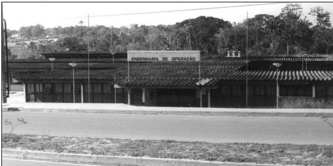
Figura 6 - Fachada da UTAM, 1975
