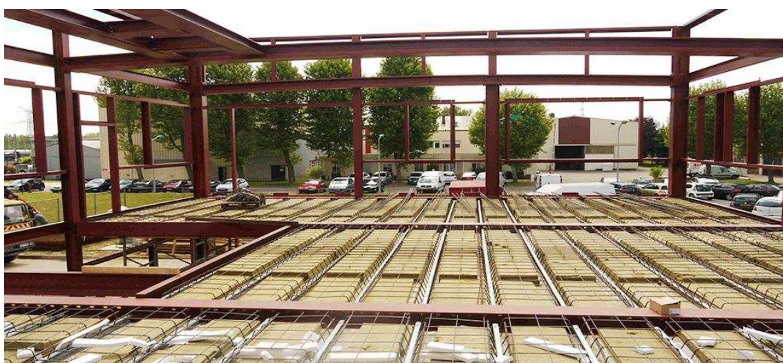
Figura 2.17. Sistema de slim floor CoSFB (BRAUN, HECHLER e OBIALA, 2014).
