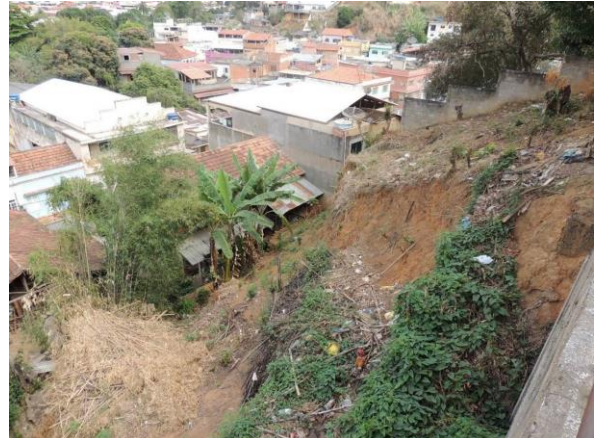
Figura 28. Vista frontal do setor de risco com detalhe para os indícios de instabilidade da encosta. (Setor 37 - R4). Bairro Vila Laroca.
