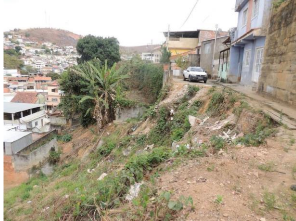
Figura 35. Vista parcial do setor de risco com detalhe para os indícios de instabilidade em talude a montante dos domicílios (Setor 25 - R3). Praça da Bandeira.
