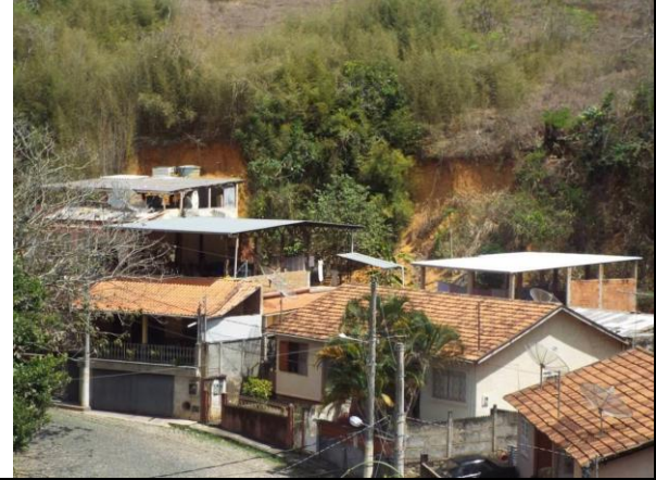
Figura 34. Vista parcial do setor de risco. Detalhe para o talude de corte a montante das casas mais acima da encosta. (Setor 34 - R3). Vila Caxias.
