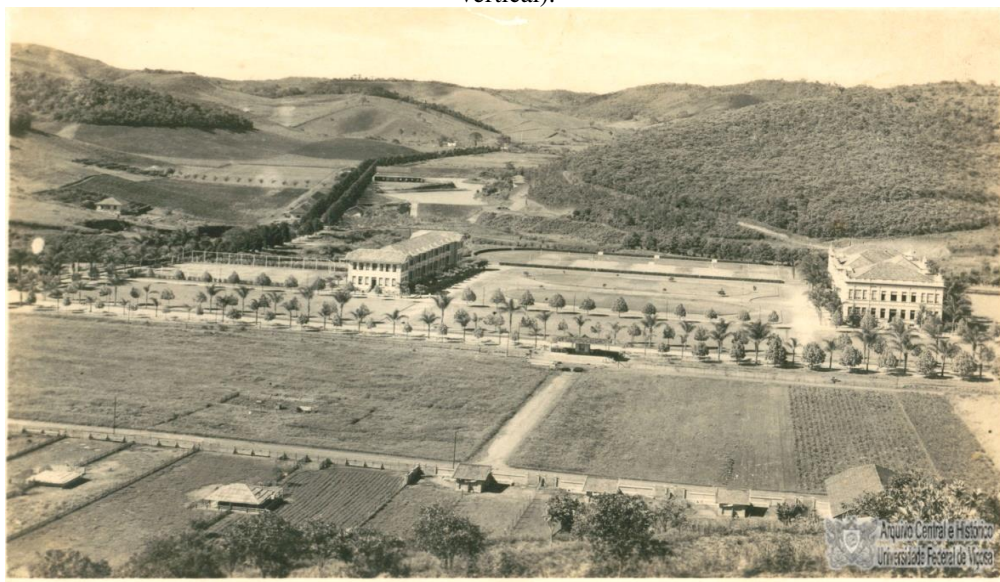
Figura 16 – Vista parcial da ESAV ([s/d]). Em destaque está o edifício principal e o dormitório dos alunos, tendo a praça de esportes ao centro. Percebe-se a organização do espaço ocupado pela Escola, com a delimitação dos campos experimentais, a ornamentação em torno do edifício central e do dormitório, bem como a arborização da Avenida Principal (na horizontal) e da Avenida da Agronomia (na vertical).
