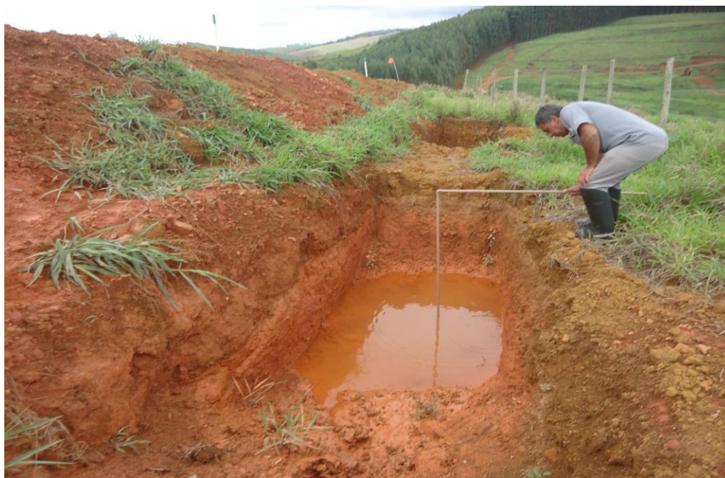
Figura 32 – Adaptação construída a partir de dois canos de PVC de 1,50 metros conectados por um joelho, formando uma haste em formato de L, medindo a parte central do poço de decantação.
