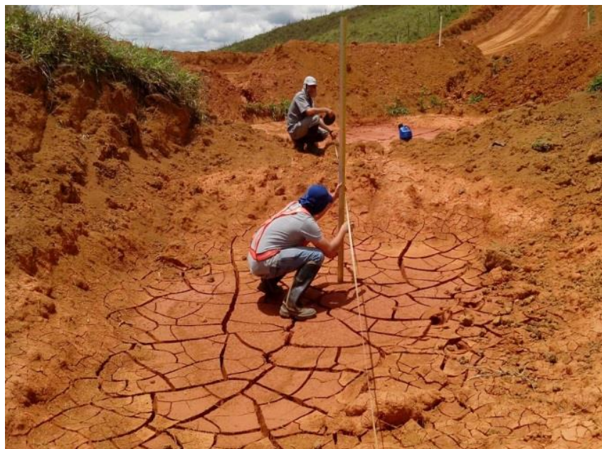
Figura 20 – Remedição com o auxílio de uma fita métrica de 50 metros após a retirada do sedimento dos poços de decantação na estrada de acesso ao corpo de mineração no município de São Sebastião da Vargem Alegre, MG.
