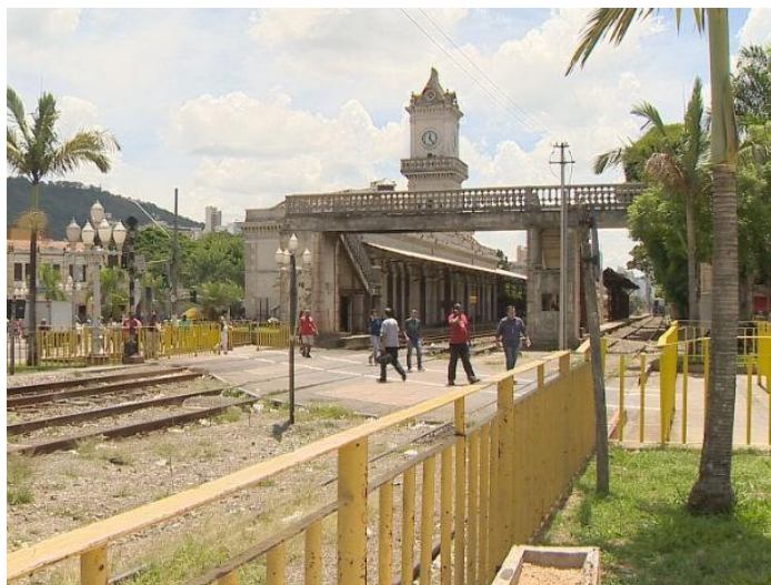
Figura 11 – Passagem de nível sob a linha férrea na região central de Juiz de Fora (Ao fundo, destaca-se o relógio da Estação Central).
