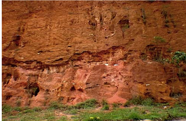
Figura 9 – Talude de corte do solo SP
