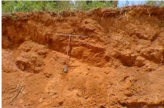
Figura 8 – Talude de corte do solo PVB
