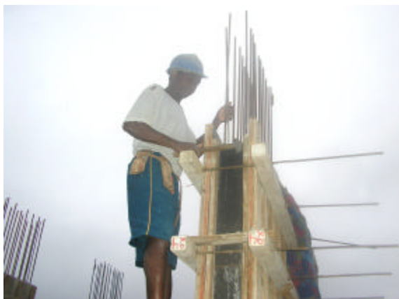
Figura 7 - Carpinteiro desmontando pilar
