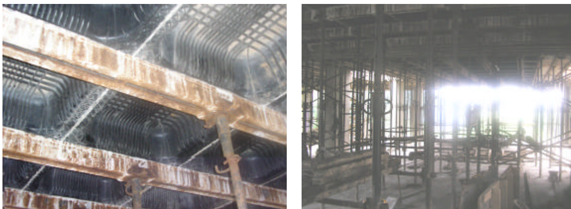
Figuras 8 e 9- Estrutura da laje armada
