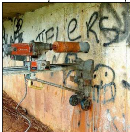
Figura 0.32 – Extração de testemunho no ponto 1.
