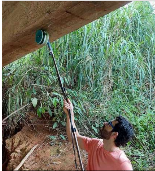
Figura 4.10 – Realização do ensaio de potencial de corrosão na longarina da Ponte sobre o Ribeirão Teixeira.
