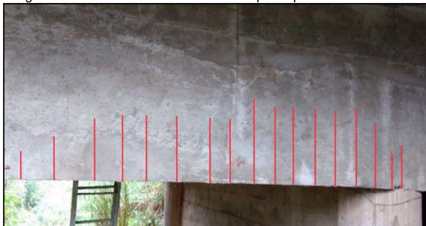
Figura 0.22 – Armadura transversal composta por estribos verticais.
