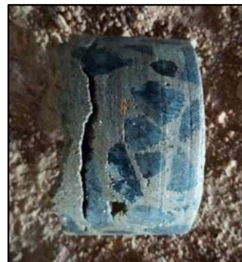
B - Pedaco do testemunho com a fissura
