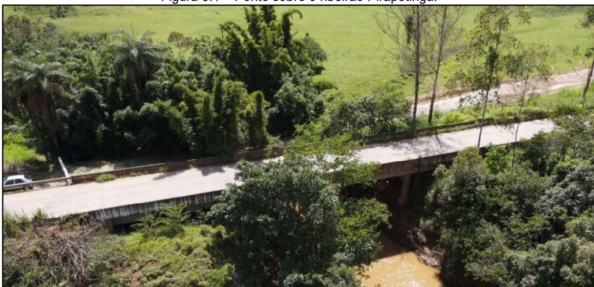
Figura 0.1 – Ponte sobre o ribeirão Pirapetinga.
