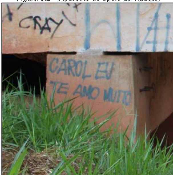
Figura 0.2 – Aparelho de apoio do viaduto.
