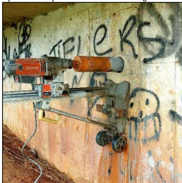
Figura 4.14 – Realização da extração de testemunho na longarina do Viaduto de Coimbra I.
