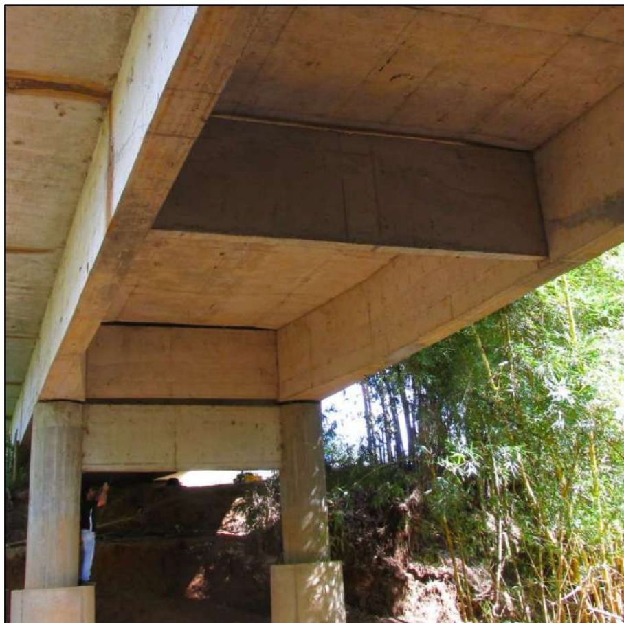
Figura 0.2 – Condição geral da ponte sobre o rio Pirapetinga.
