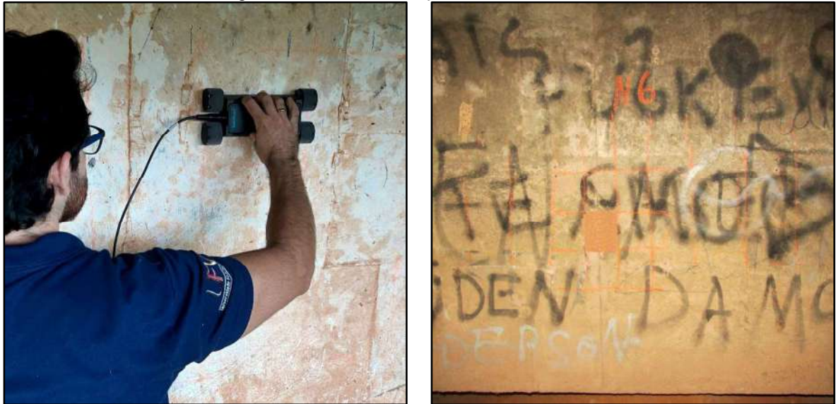
A - Execução do ensaio de pacometria
