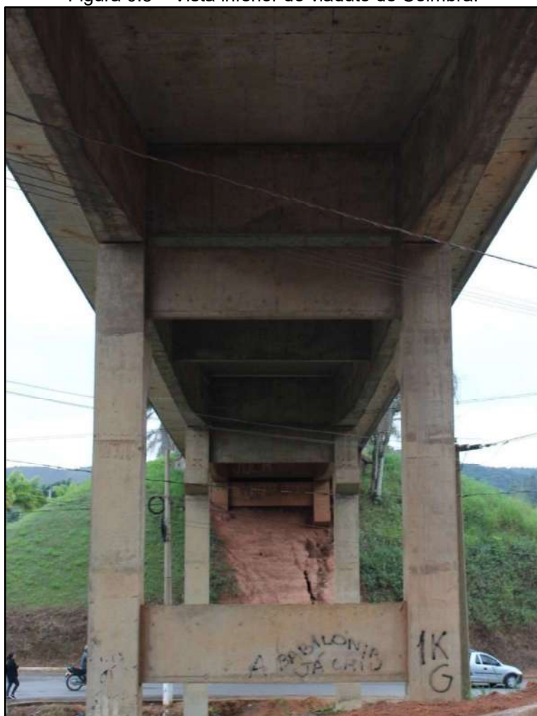
Figura 0.3 – Vista inferior do viaduto de Coimbra.
