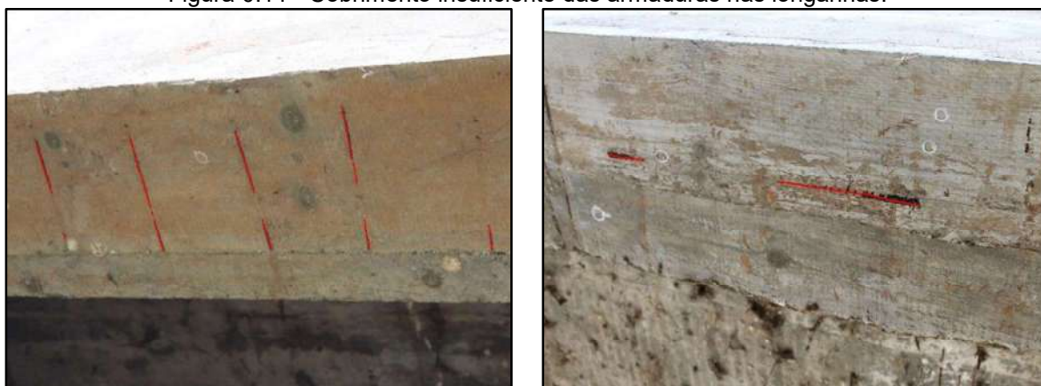
B – Armadura de flexão com cobertura insuficiente
