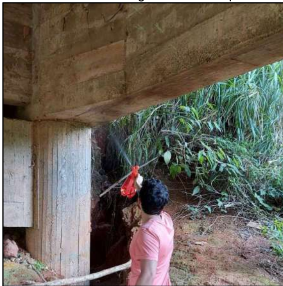
A – Molhagem da estrutura
