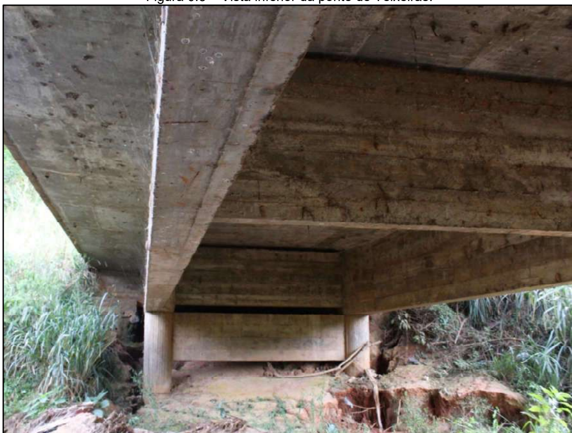
Figura 0.3 – Vista inferior da ponte de Teixeira.
