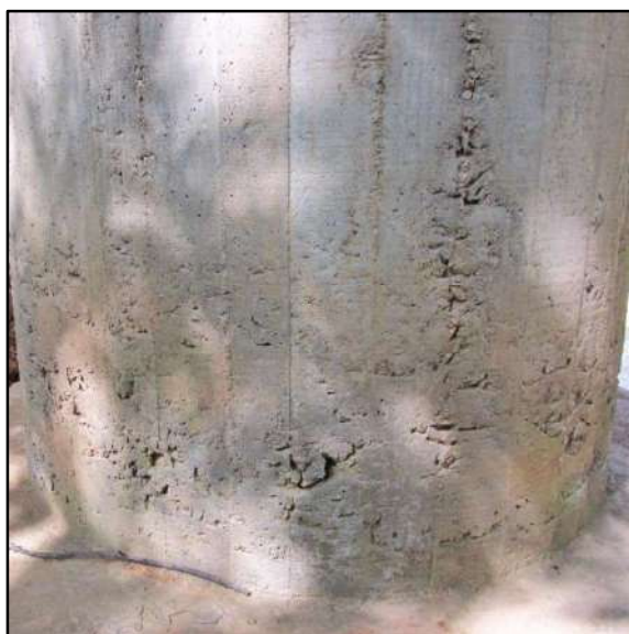
A - Bicheira de concretagem na base do pilar
