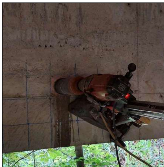
Figura 0.24 – Extração de testemunho no ponto 1.
