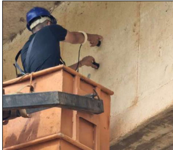
Figura 4.4 – Ensaio de ultrassonografia em uma das longarinas do Viaduto de Coimbra I.
