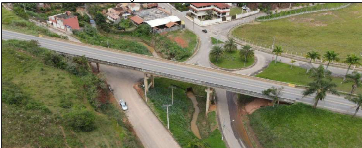
Figura 0.1 – Viaduto de Coimbra.
