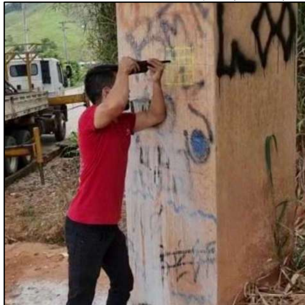
Figura 4.3 – Realização do ensaio de esclerometria no pilar (Ponto 3) do Viaduto de Coimbra I.
