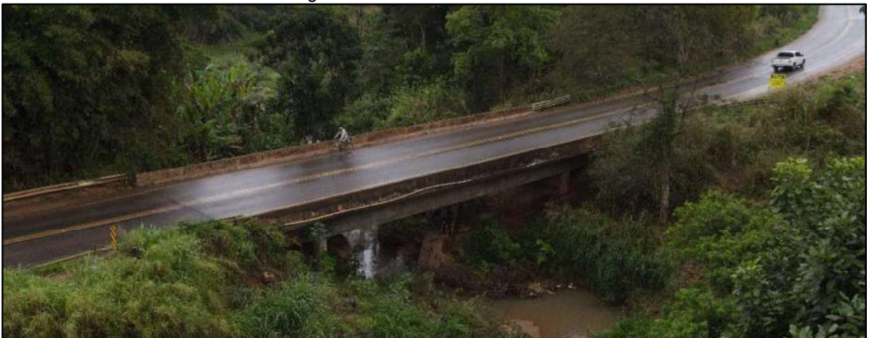
Figura 0.1 – Viaduto de Coimbra.
