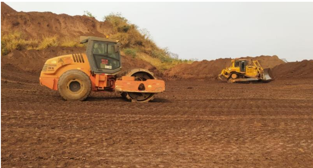
Figura 17 – Compactação de camadas de rejeitos nas pilhas
