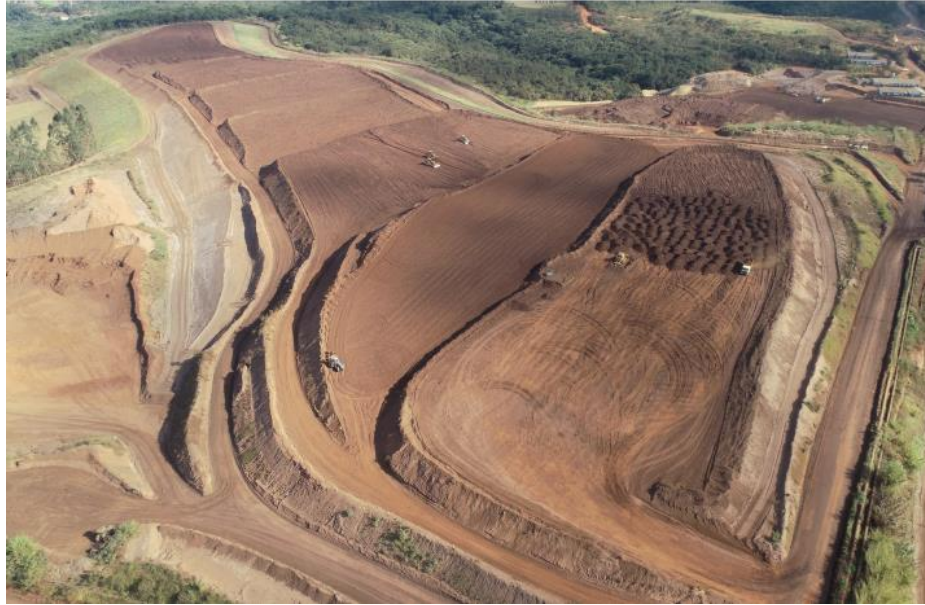
Figura 16 – Tratamento de camadas de rejeitos nas pilhas
