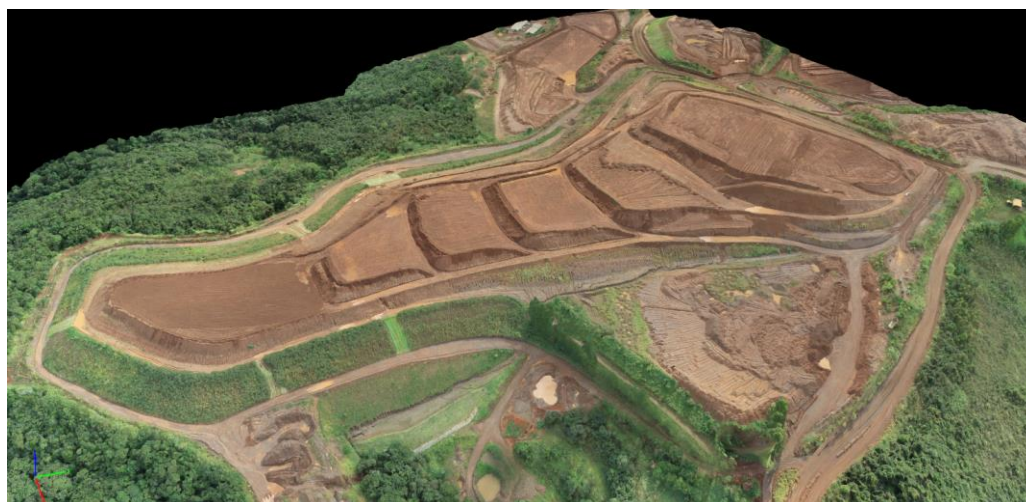
Figura 15 – Pilha de rejeitos filtrados e compactados
