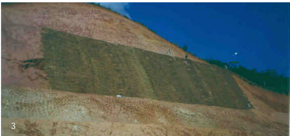
Figura 2. Vista geral do talude onde foi instalado o ensaio (1) e os processos de coveamento (2) e implantação da biomanta (3).
